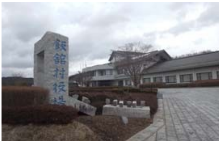
人気もない飯館村役場 まだ新しい建物だった
